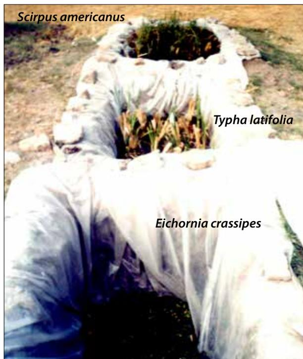
Figura 3. Diseño del humedal artificial.
